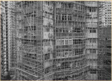
Andamiajes de construcciones chinas
