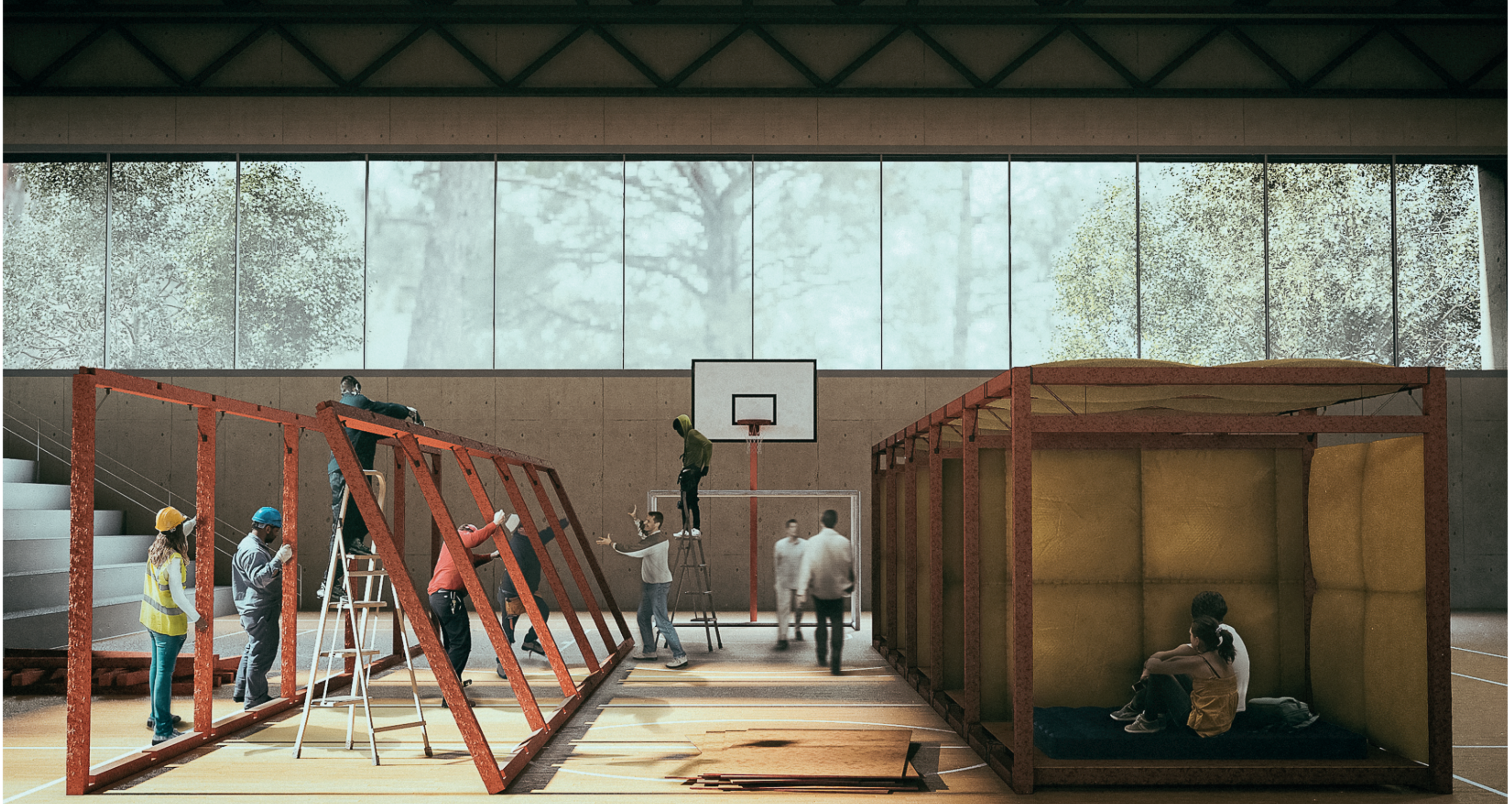
IMAGEN 2/ VISTA FRONTAL DE PROCESO DE MONTAJE Y PRESENTACIÓN DE MÓDULO
