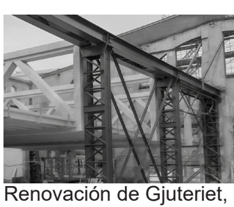
Renovación de Gjuteriet, 2023.
