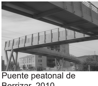
Puente peatonal de Berrizar, 2010.
