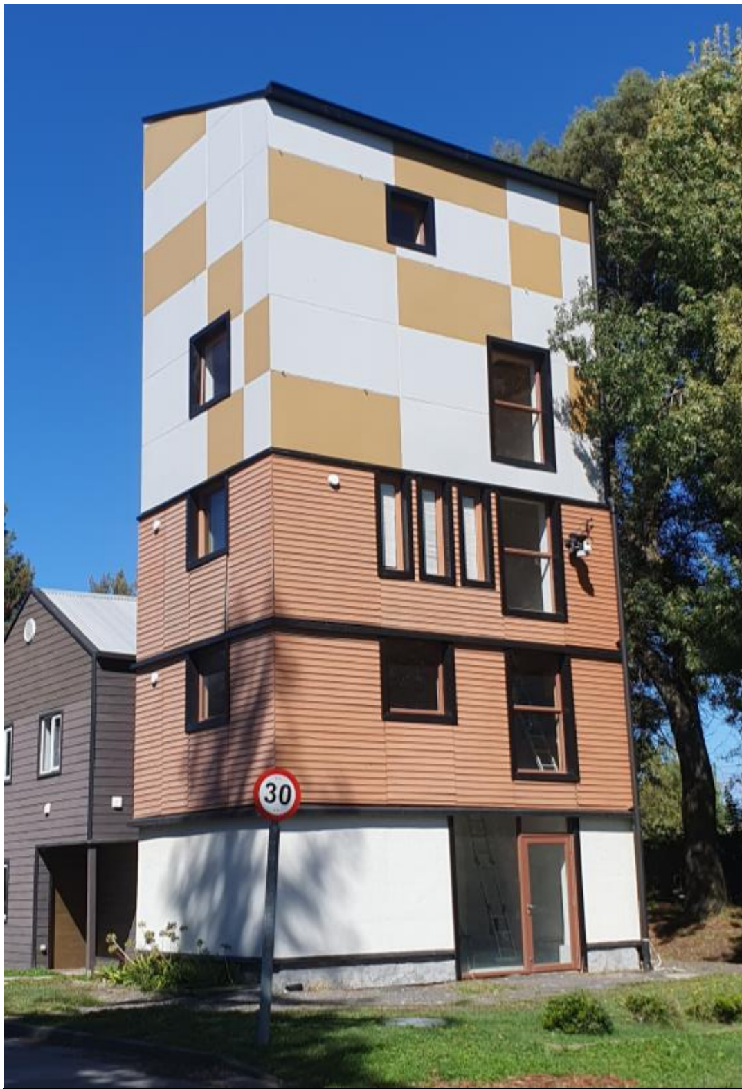
PymeLab Torre de 5 pisos de madera contralaminada.
