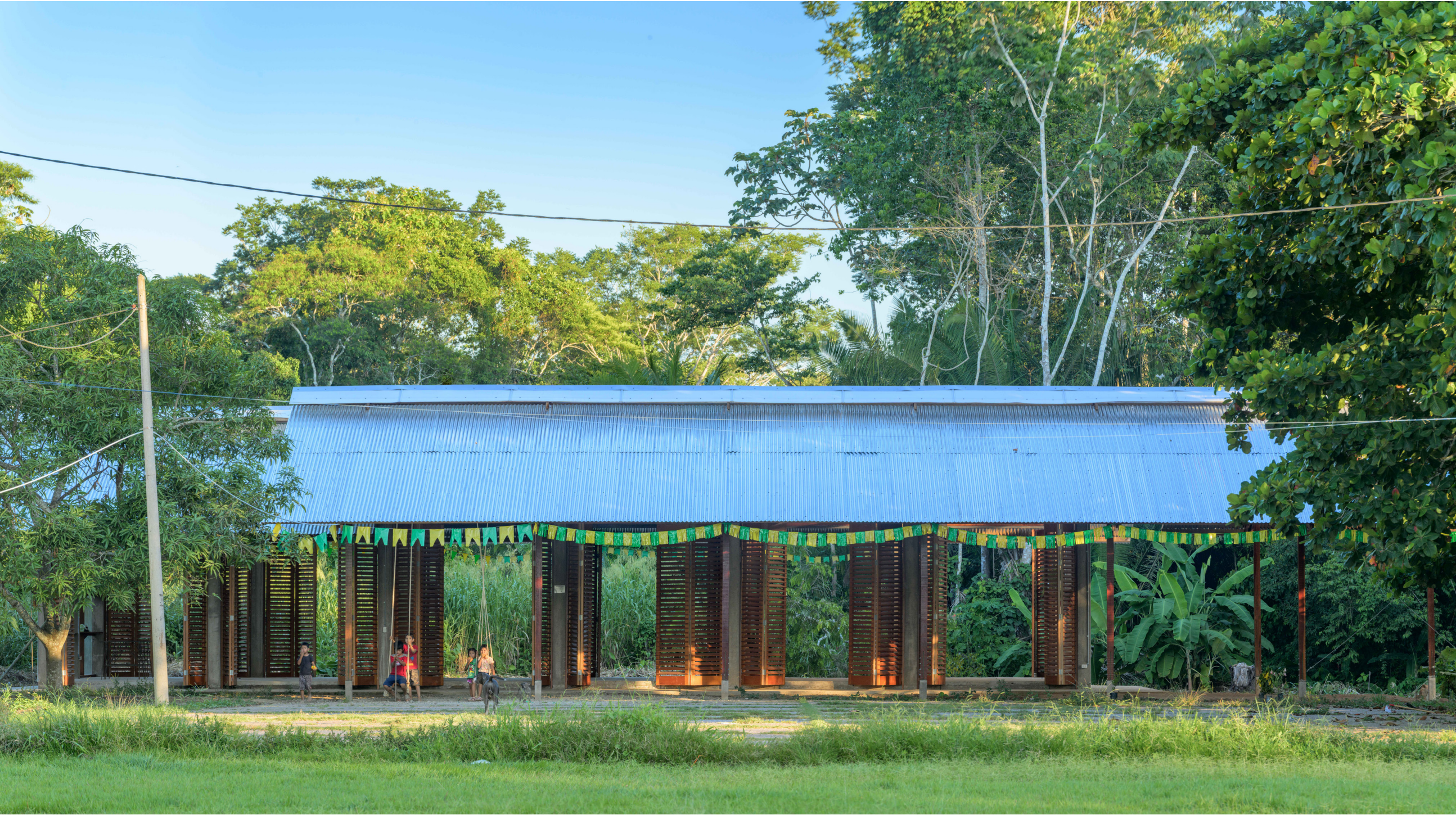
Fachada frontal principal del proyecto
