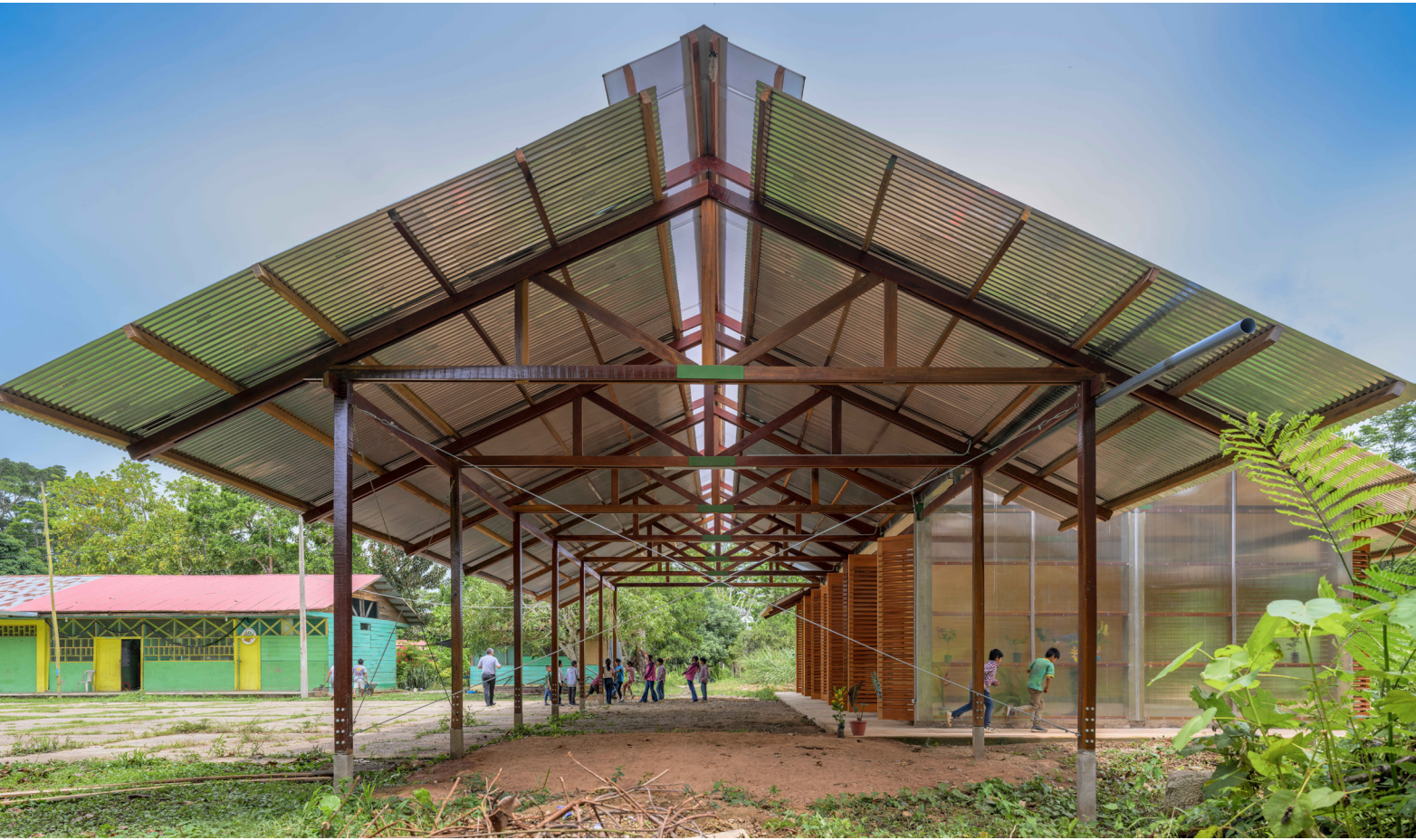
Sistema de tijerales que configuran el espacio libre cubierto, resuelto con uniones con placas metálicas y pernos.
