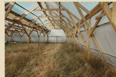
Figura 3. Vista de la nave poniente.
