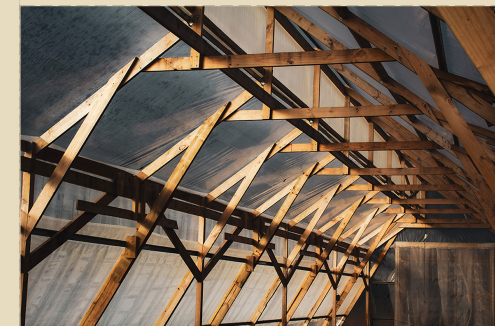
Figura 2. Vista de refuerzo perimetral y cerchas.
