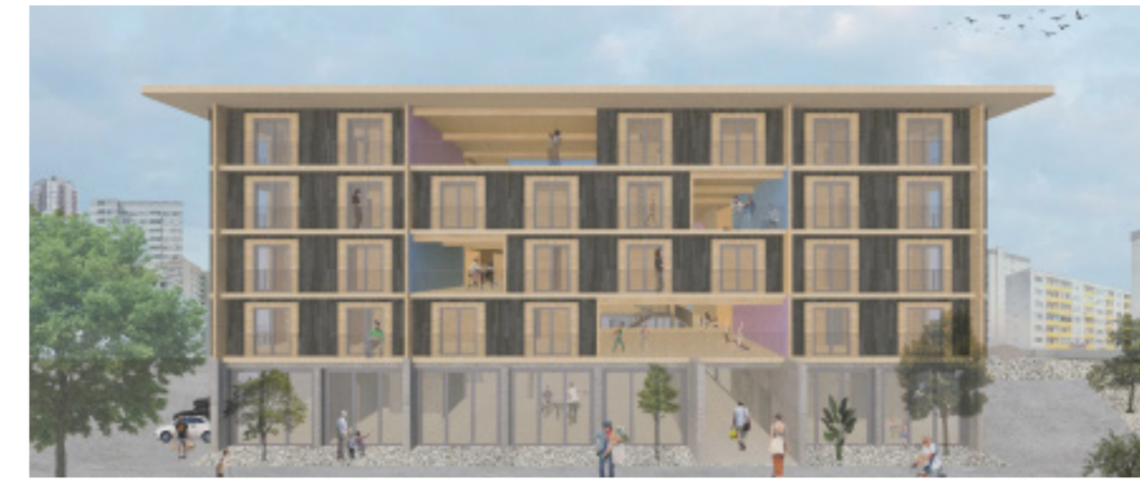
La materialidad de la fachada corresponde a madera carbonizada para la protección contra la humedad.
