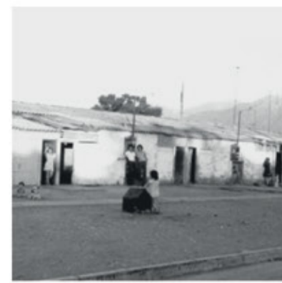
Viviendas de emergencia (1951) destinada para grupo familiar de 5 personas
