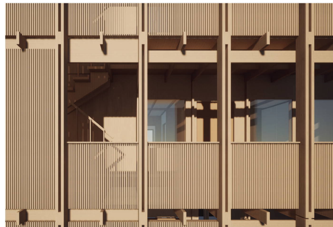
Vista Exterior Fachada: pilares, celosía y barandas
