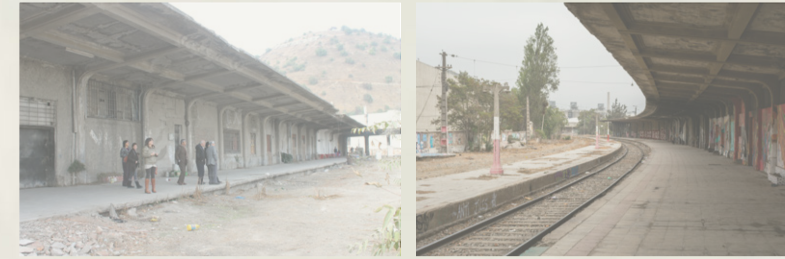
Estado actual de la Antigua Estación de trenes La Calera.
