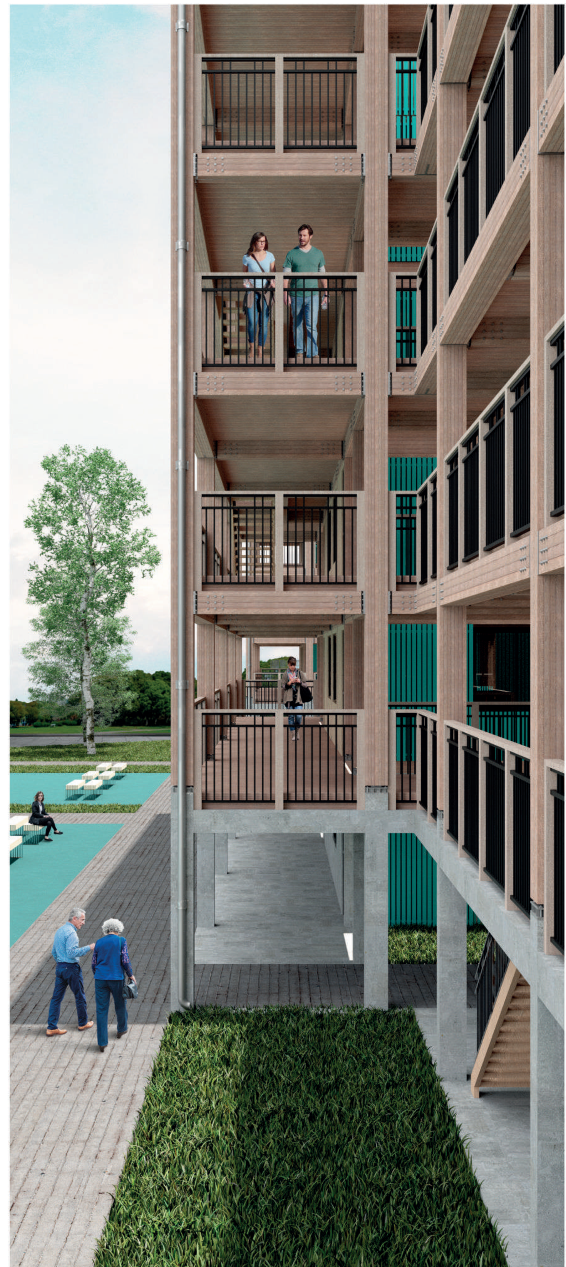
Vista de los niveles. Primer nivel de Hormigón Armado para evitar problemas por humedad y mantener la madera elevada para protegerla.
