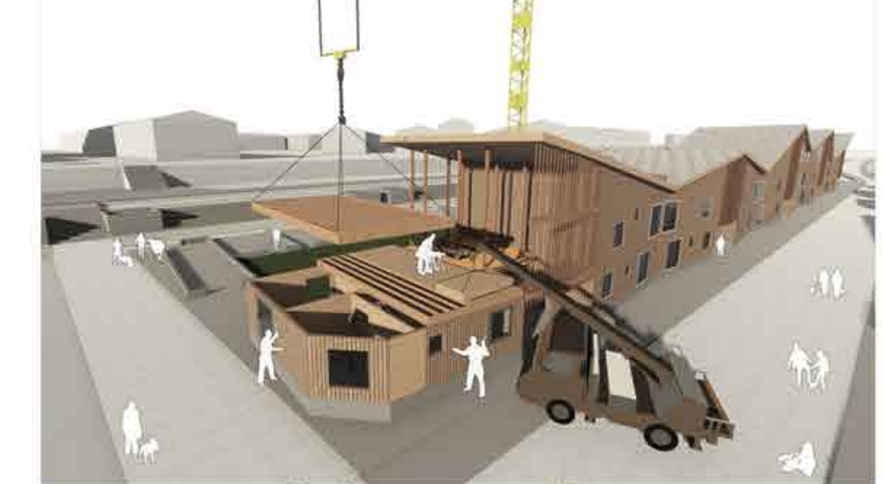
5. MONTAJE DE LAS VIGAS ENTRE PISO Y REVESTIMIENTO
