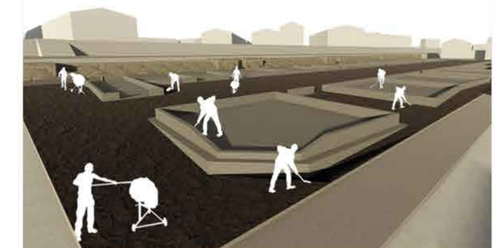
2. CREACIÓN DE RADIER Y ZÓCALO DE HORMIGÓN EN TERRENO
