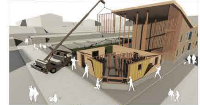
3. MONTAJE DE PANELES PERIMETRALES 4. MONTAJE DE PANELES INTERIORES
