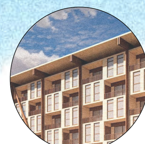
Proyección de la cubierta por sobre las fachadas para proteger la madera de las condiciones climáticas
