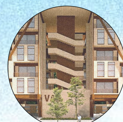
Rigidización de los volúmenes longitudinales mediante un núcleo de hormigón para circulación vertical
