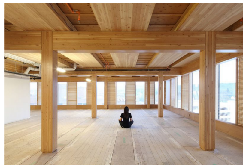
Figura 1: Edificio de madera Contralaminada
