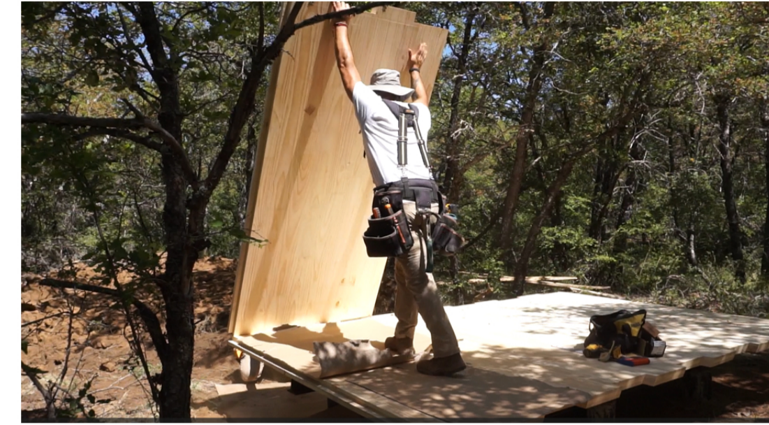
Construcción de la obra
