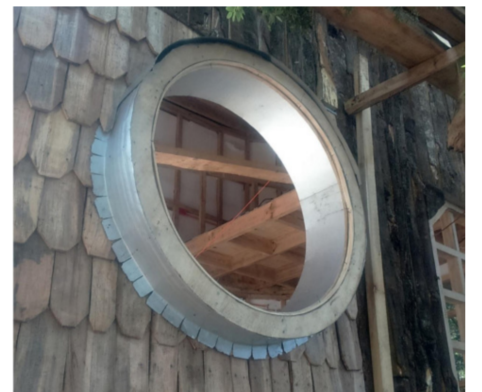
DETALLE ESTRUCTURA GENERICA BOWINDOWS
