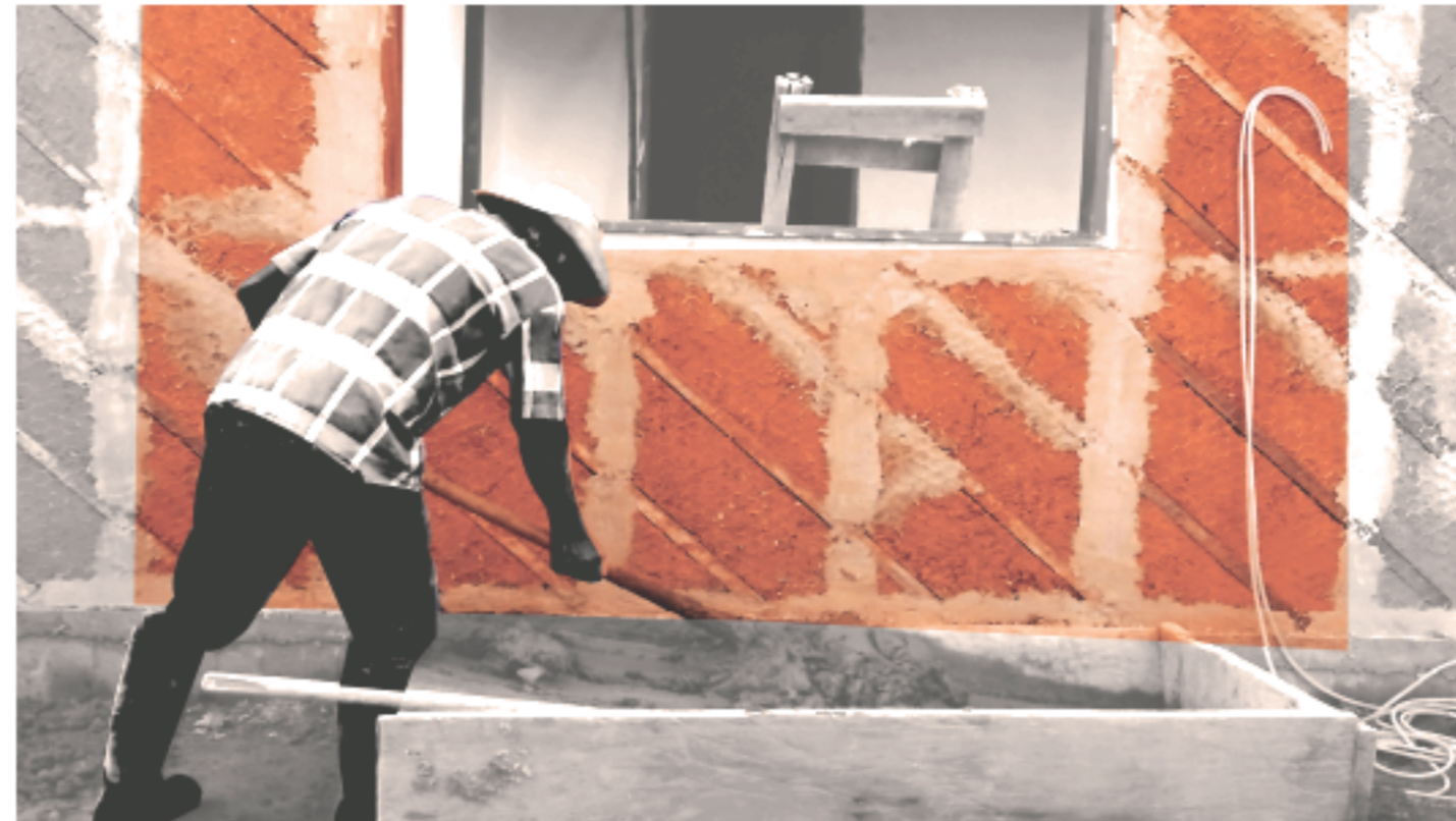
Preparación del muro y barro
