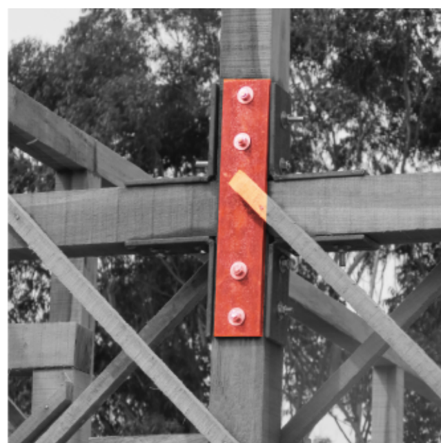
Unión y entre elementos verticales y horizontales
