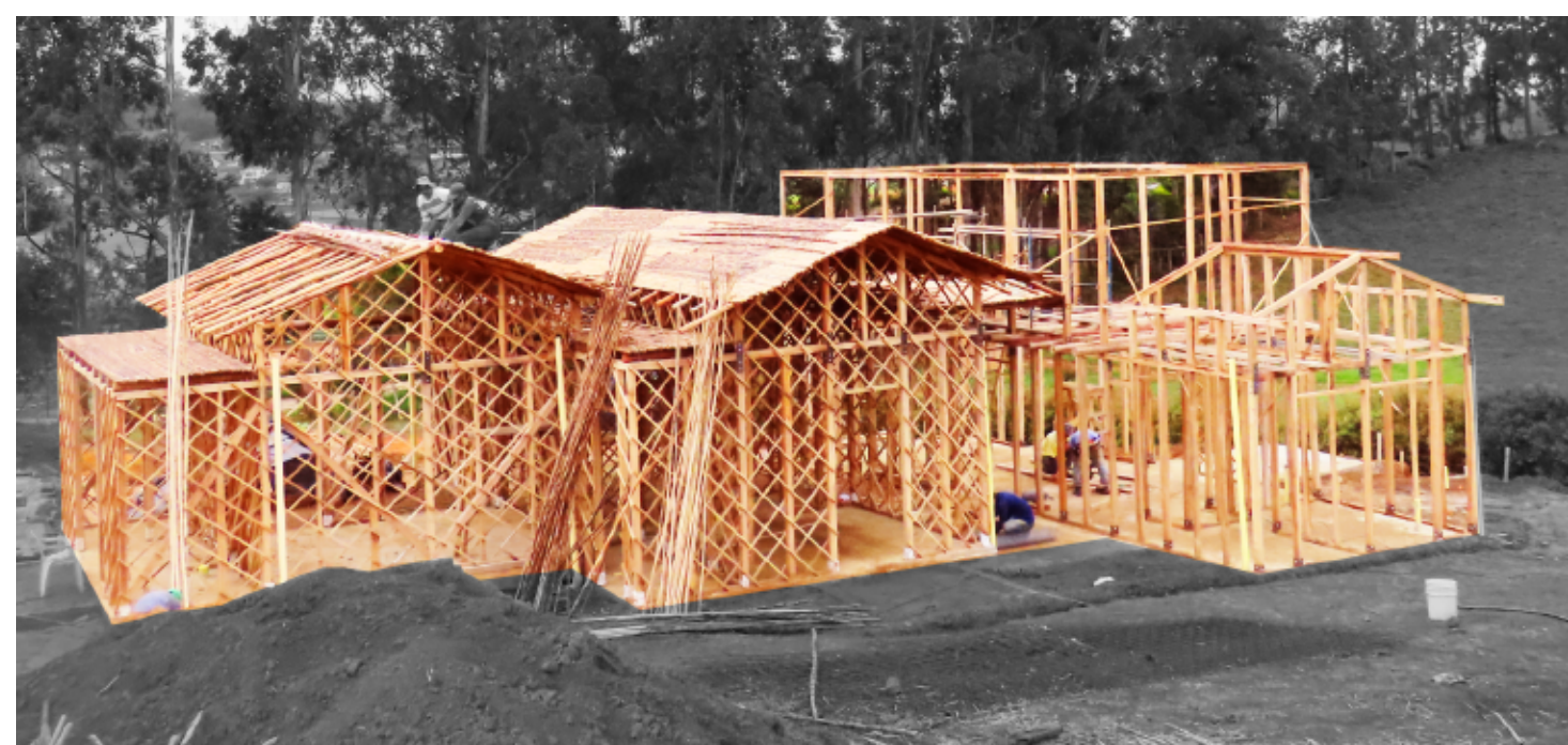
Armado de modulos de madera
