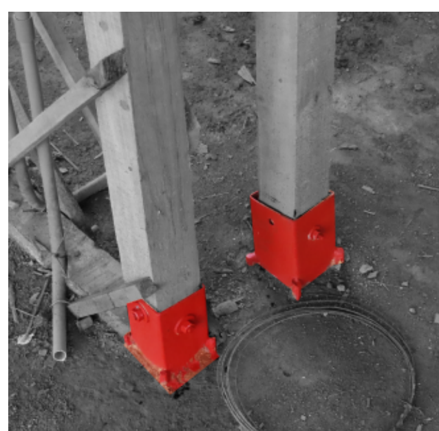
Unión entre elementos estructura y cimentación.
