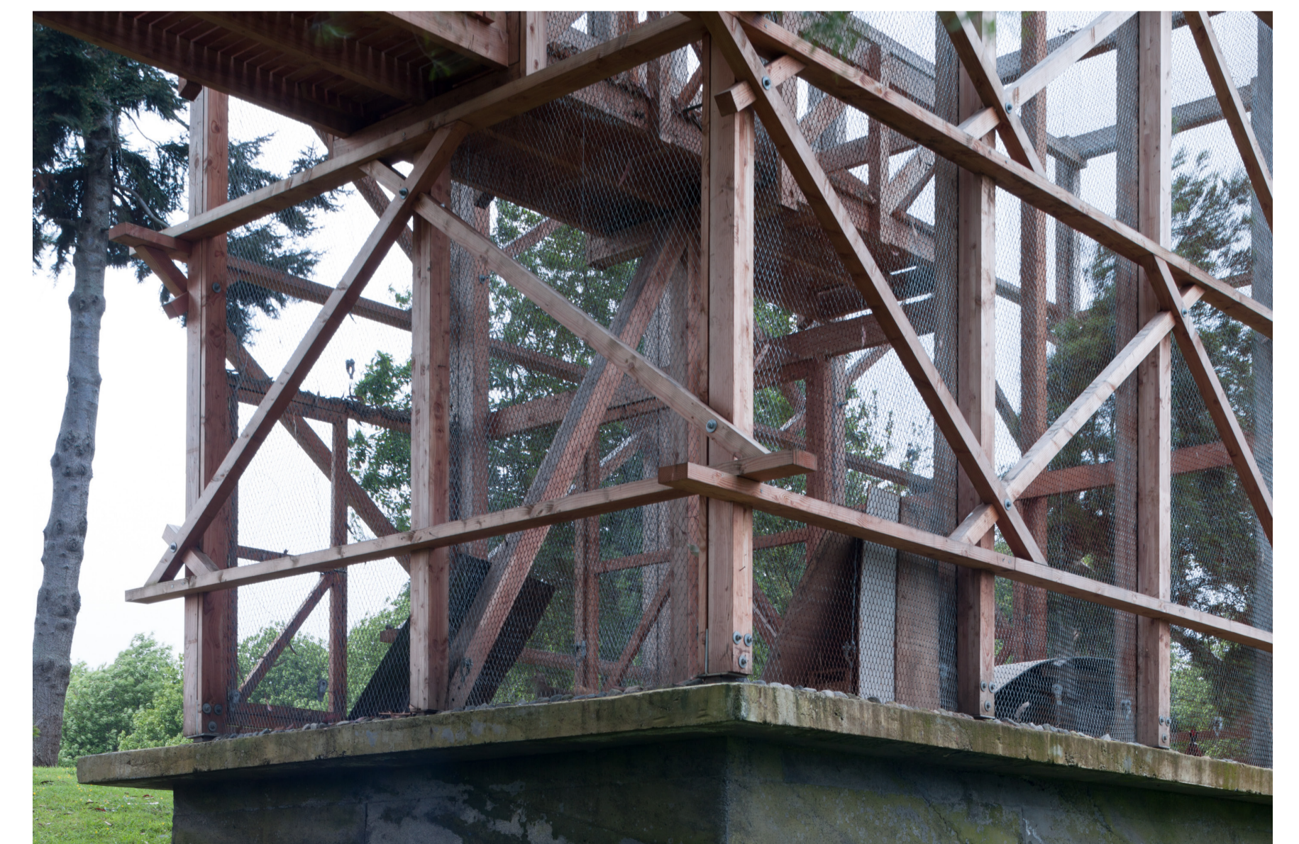
VISTA 03 : Vista exterior llegada madera-hormigón
