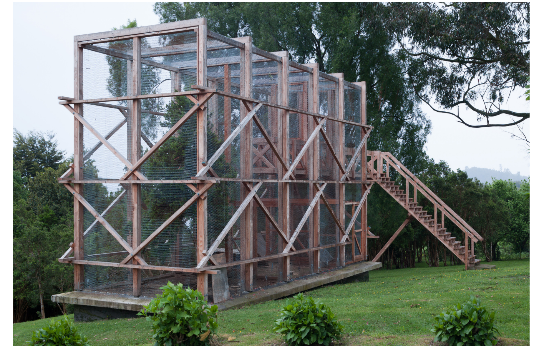
VISTA 01 : Vista exterior hacia fachada suroeste
