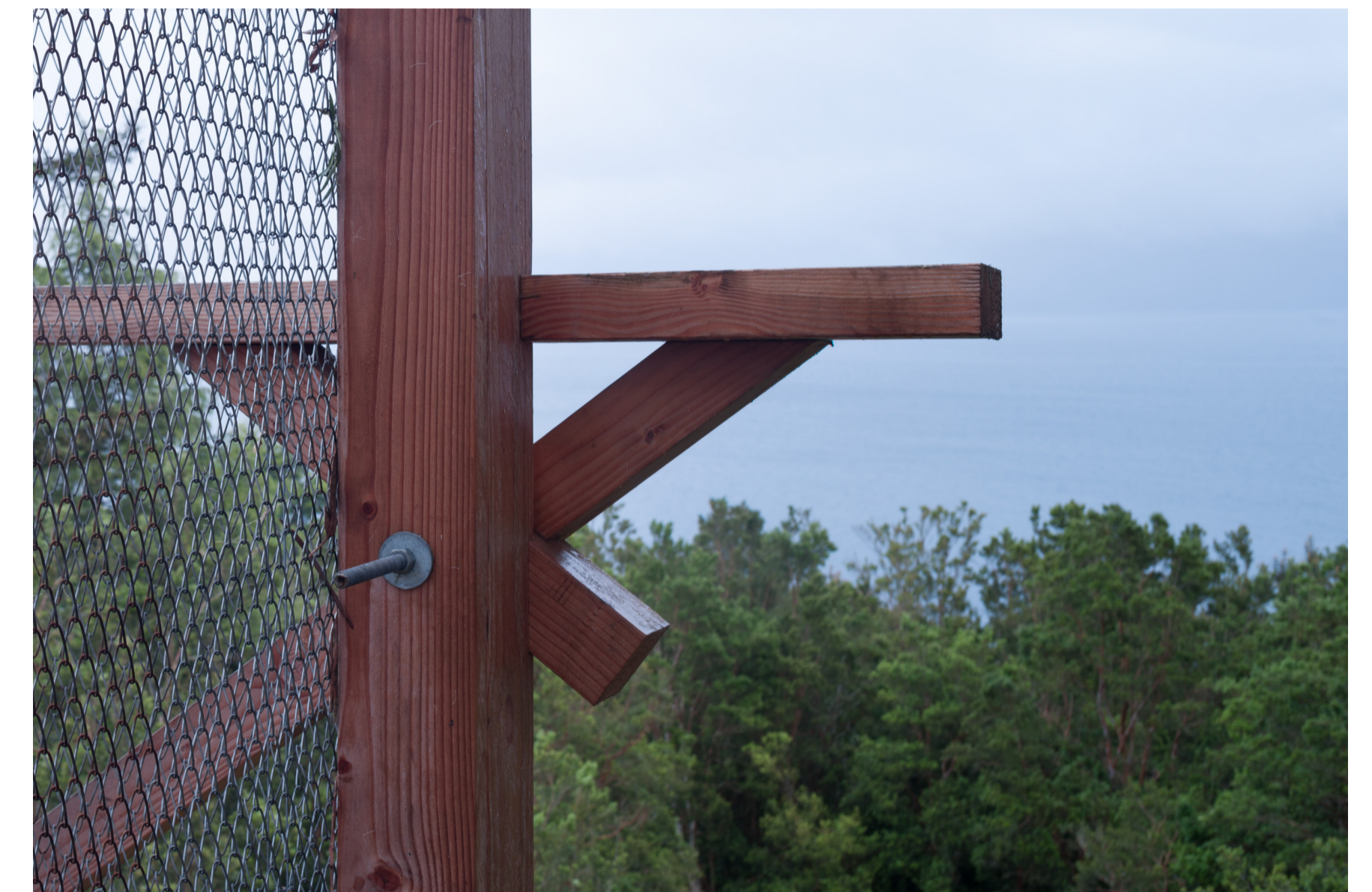
VISTA 02 : Vista detalle unión arriostramiento
