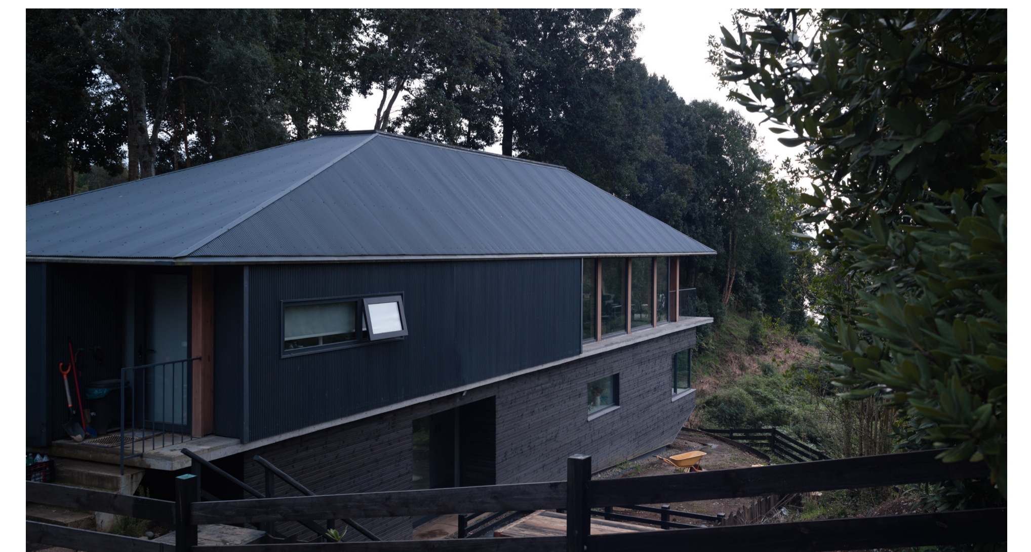
VISTA 03: Vista exterior hacia fachada suroeste
