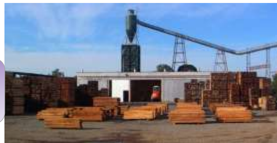
Instalaciones Planta Maderas Fuente: Propia.
