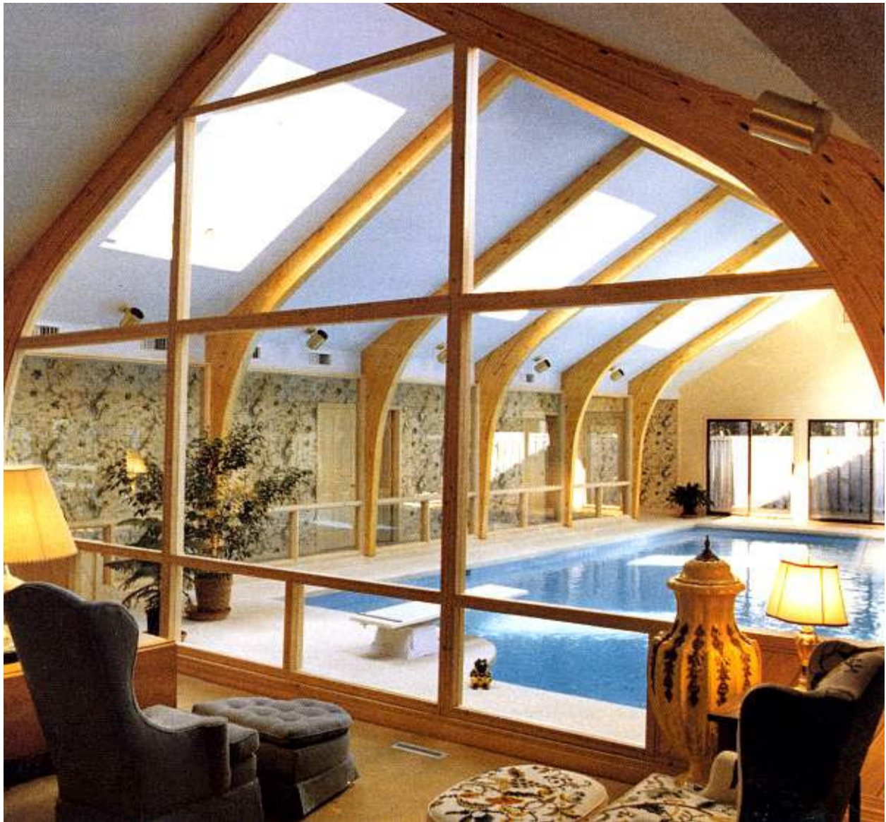
Foto 8.4 Estructura Tipo Marco
