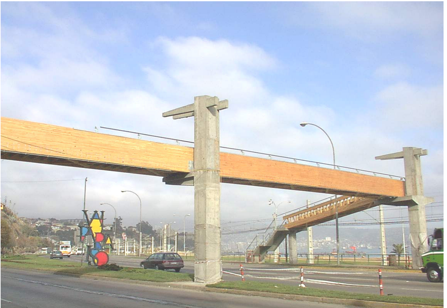
Foto 8.2 Viga Recta de Madera Laminada trabajando como Pasarela en Valparaíso.
