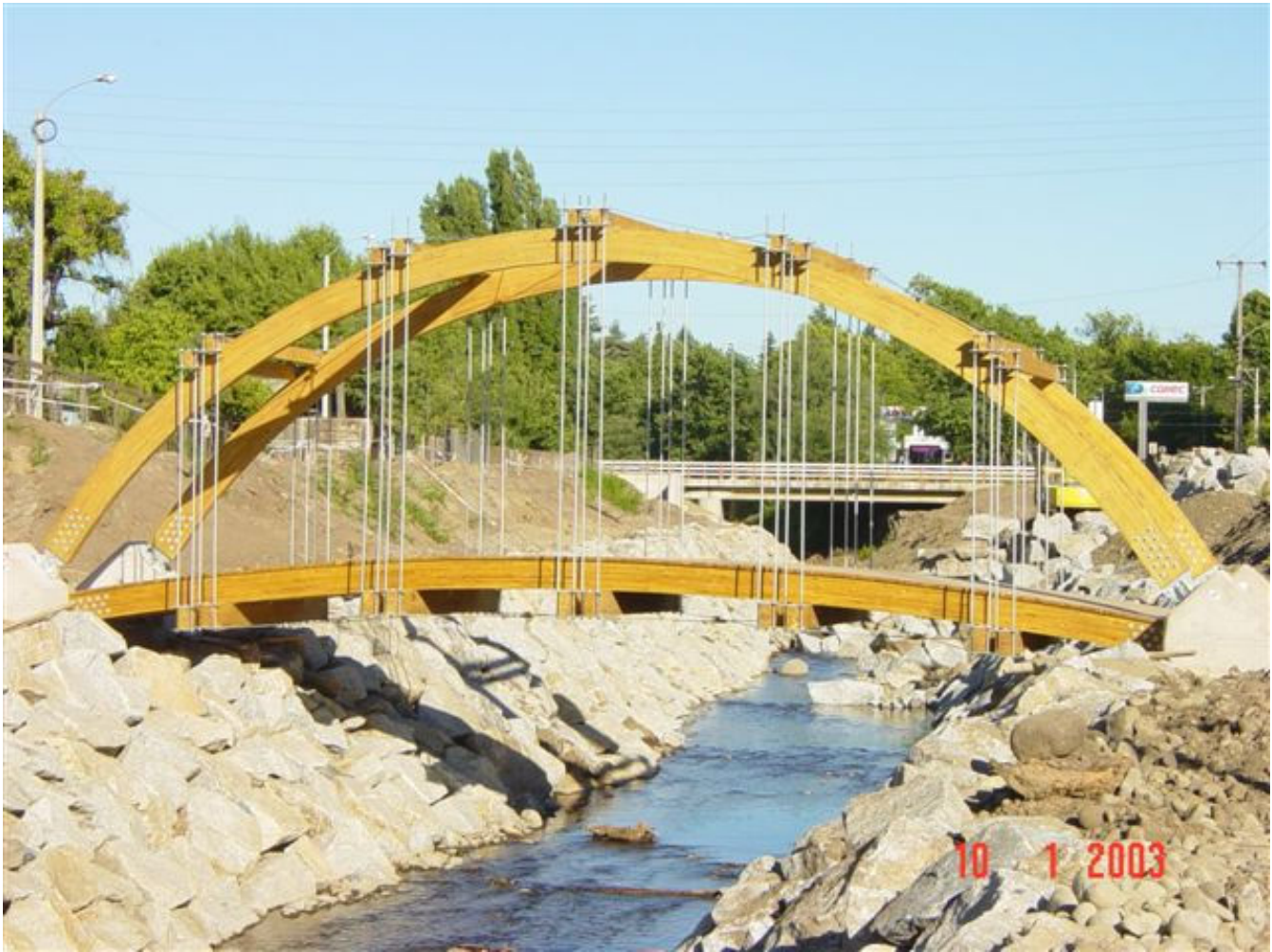
Foto 8.3 Pasarela sostenida por un Arco
