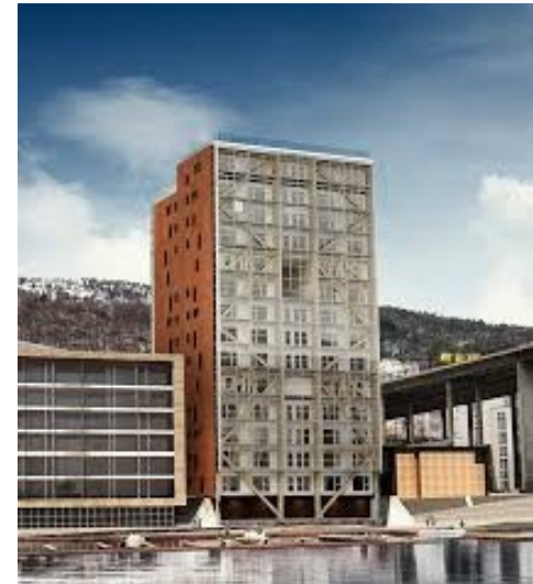
Bergen, Noruega Diagonales madera laminada 14 pisos, 45 m
