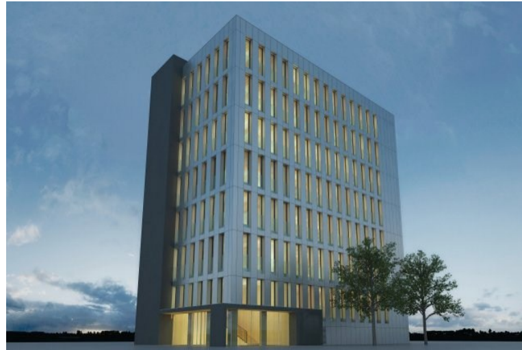
LCT One, Austria 8 pisos híbrido, núcleo de hormigón, columnas madera laminada
