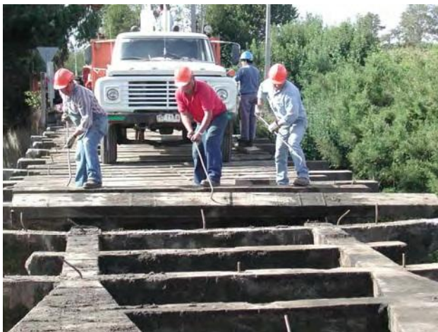
Figura 6.3: Retiro de tabloncillos de resistencia
