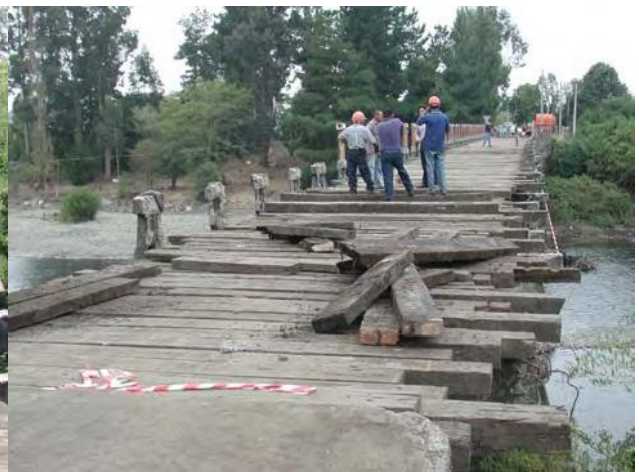
Figura 6.4: Retiro de barandas y pasillos
