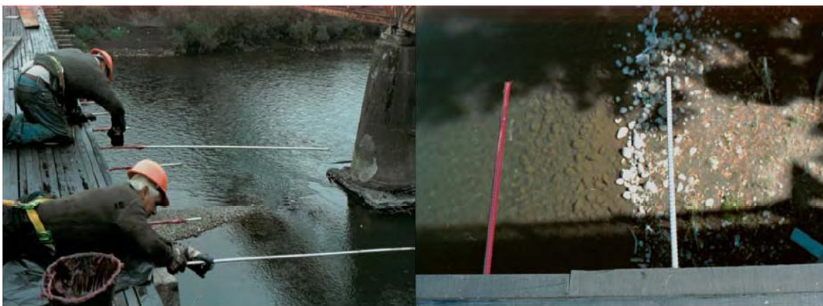
Figura 7.6: Proceso de engrasado manual (izquierda), diferencia entre barra engrasada y no engrasada (derecha).
