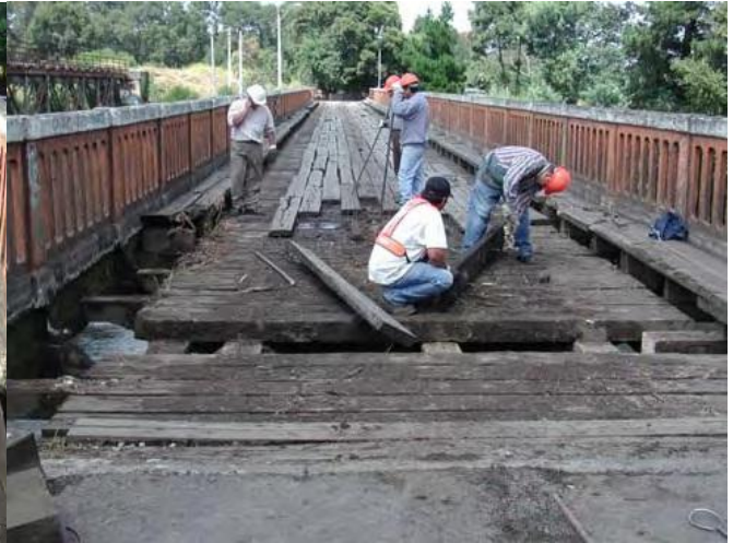
Figura 6.2: Retiro de tabloncillos de rodado
