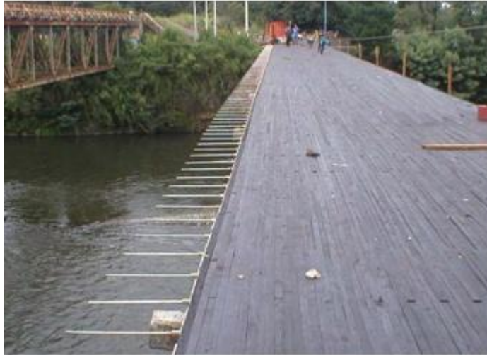
Figura 6.22: Vista general de un tablero de madera tensada ensamblado
