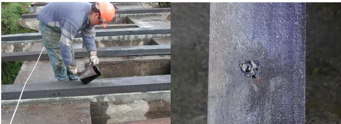
Figura 6.8: Relleno perforación con sellante asfáltico
