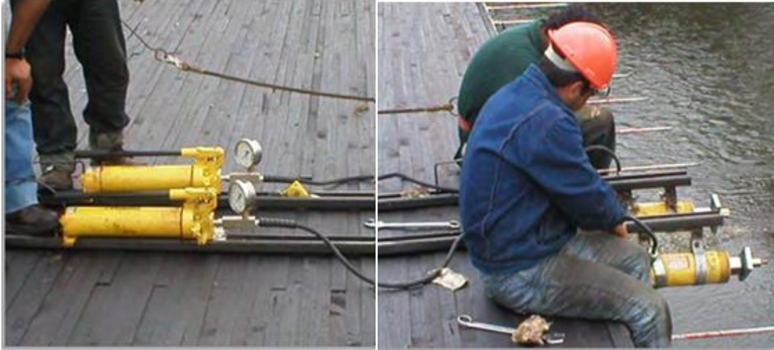
Figura 6.21: Secuencia de tensado de barras
