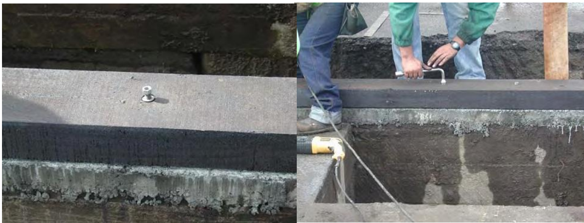
Figura 6.7: Inserción e instalación de pernos
