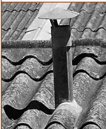
52. Salida de ducto tratado solo con sello elastomérico, con alta probabilidad de infiltración.
