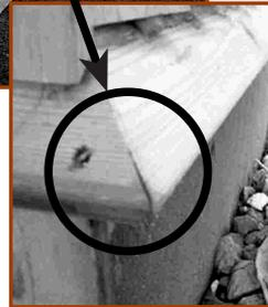
2. Piezas del tapacán de madera, deformadas, y que no han tenido mantención normal, permitiendo que el agua afecte la aislación del entretecho.
