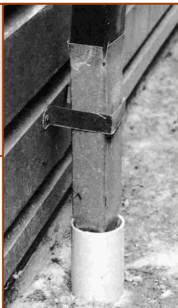
57. El ducto fue alargado por debajo del terreno, colocando una cañería de PVC que descarga a una canaleta ubicada a 50 cm -mínimos- de distancia del muro.
