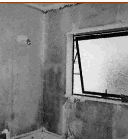
38. Aparición de moho en muro con poca ventilación.
