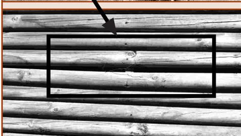
**14 y 15.** Puerta y muro sin protección e inadecuada junta, dañados por efecto de la lluvia.
