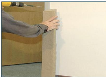
1. Para uso interior, instalar perfil de inicio a 2cm del nivel de piso terminado. Para uso exterior, fijar a 10cm del terreno.
