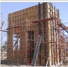
Por otro lado, al elegir un determinado desmoldante, se debe considerar la interacción de los residuos entre desmoldante y el producto de terminación del hormigón.
