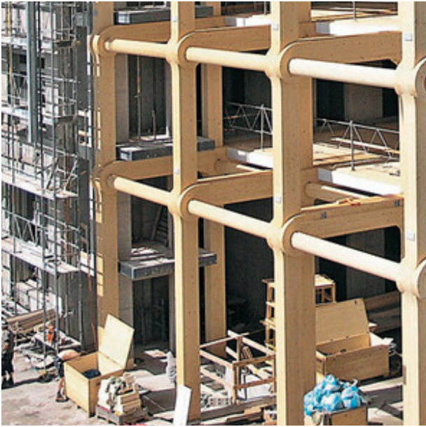
Sistema pre-fabricado de madera laminada con carpintería de armar.
