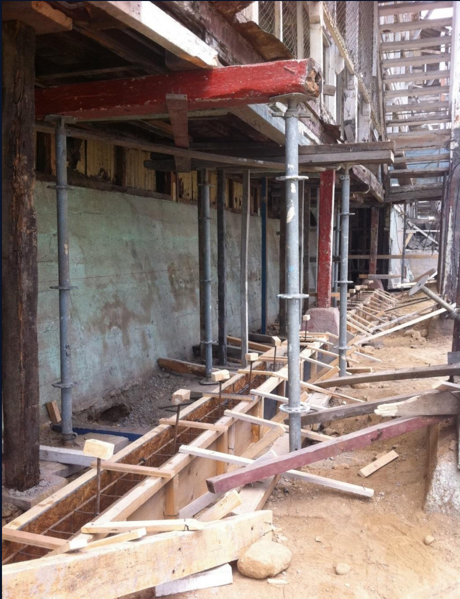
Alzaprimados y Nivelación
