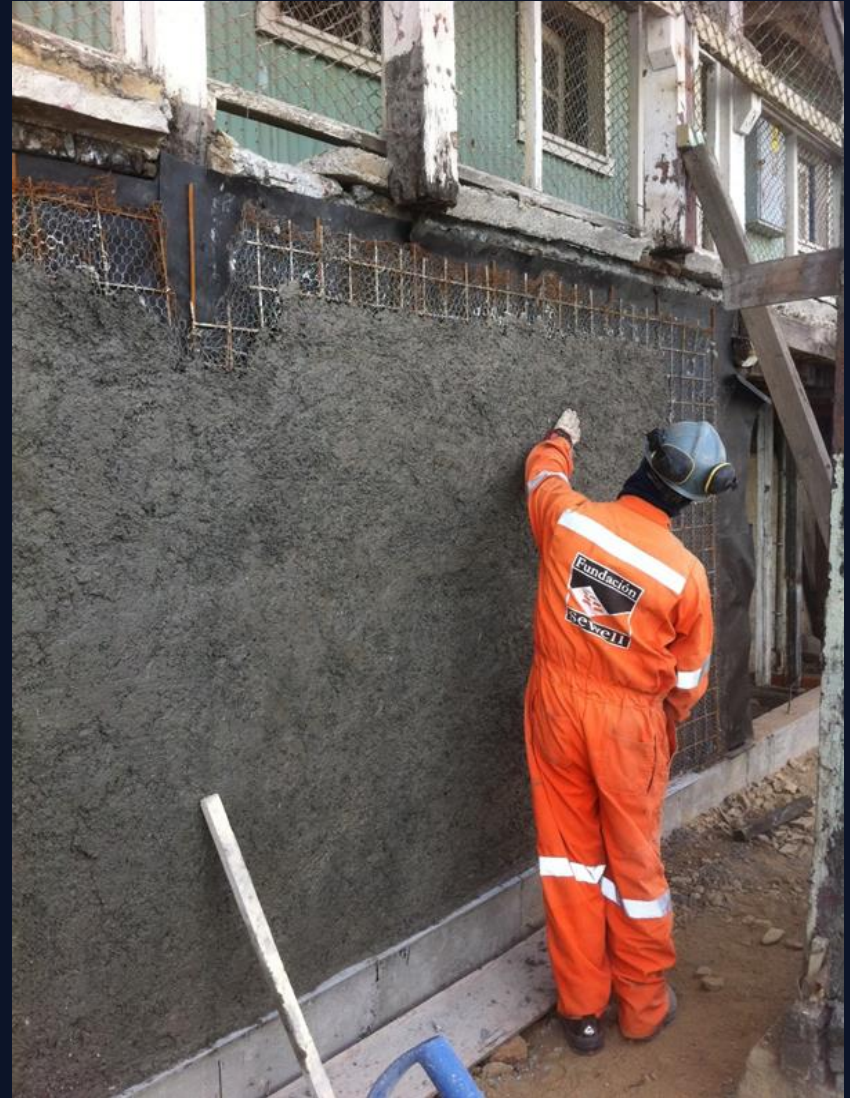
Colocación de malla y estuco
