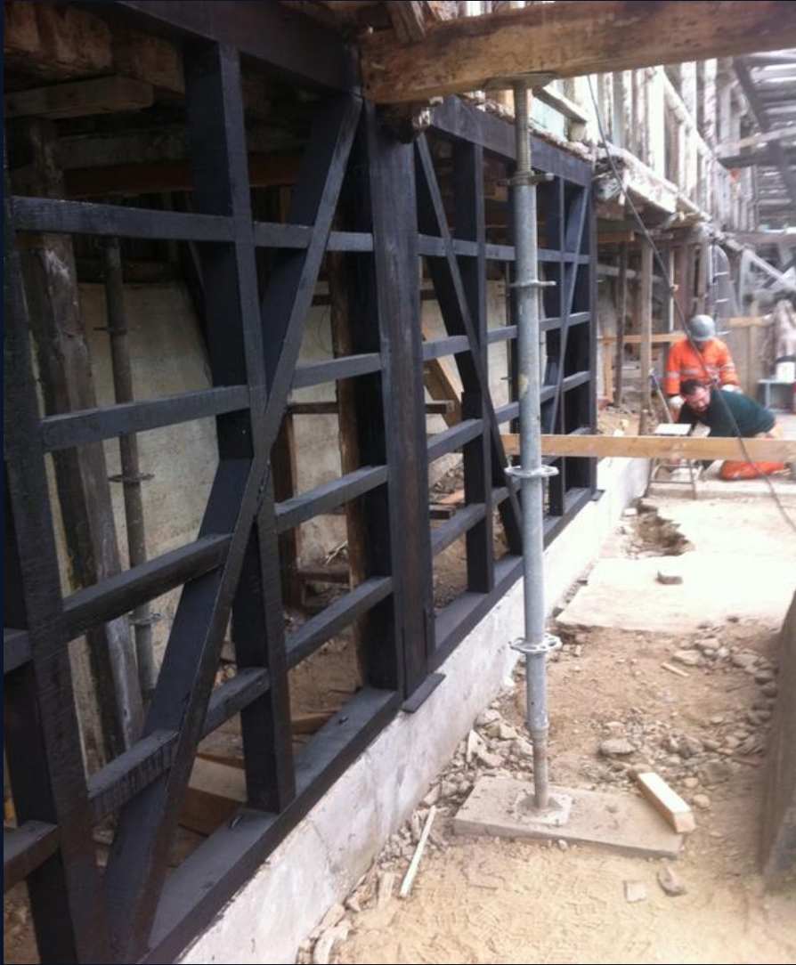
Reemplazo estructura paramento
