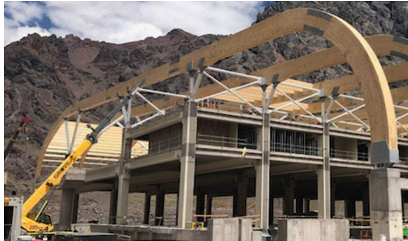
Complejo Paso Los Libertadores - Lamitec
