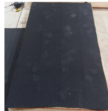
3. Colocación de la membrana acústica de caucho
