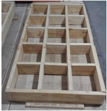
1. Armado del envigado
