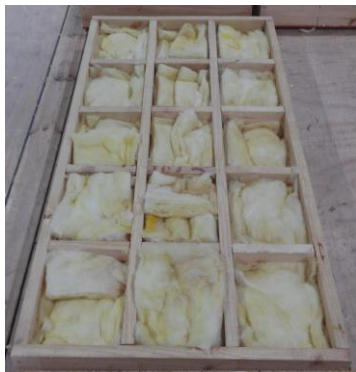
5. Colocación de la lana de vidrio entre vigas
