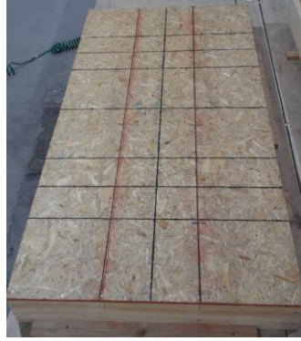
2. Fijación del primer tablero de OSB estructural
