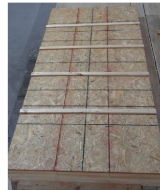
7. Colocación de los separadores de madera aserrada
