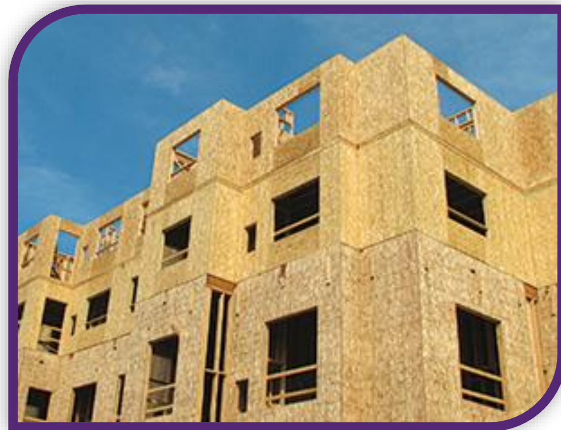
Estructura de entramado ligero de madera
