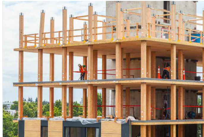
Figura 1 Construcción edificio Brock Commons (Naturally:Wood, 2017)
