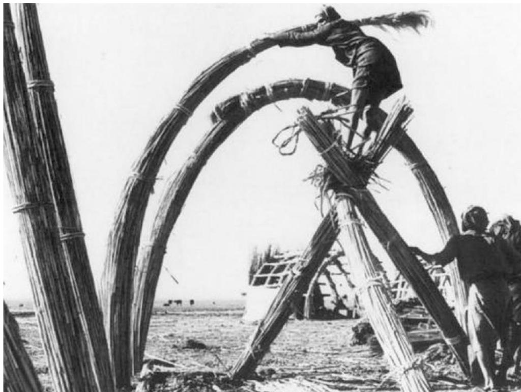
El principio consiste en construir paneles regulares y planos, los que adquieren volumen resistente al ser tensados individualmente sobre sí mismos. Esta colección de paneles se conecta para construir la geometría objetivo, y cada uno se adapta formalmente a los esfuerzos que recibe dependiendo de su posición en el arreglo.
