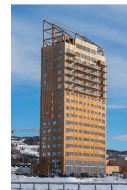
Figura 2: Edificio Mjøstårnet de 18 pisos. Brumunddal, Noruega. Fuente: (www.Madera21.cl, 2019)
