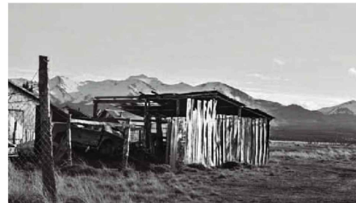
Vivienda afectada por incendios (2)
