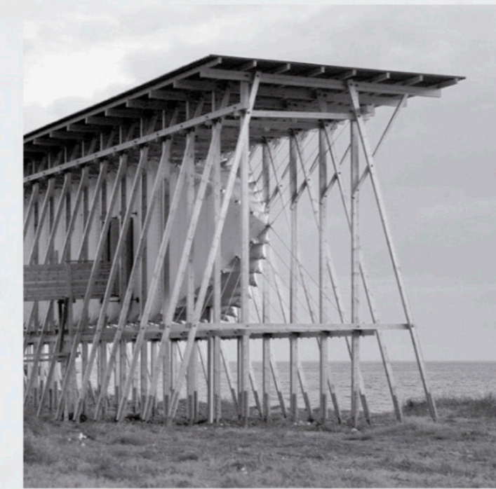
El Memorial Steilneset de los arquitectos Peter Zumthor y Louise Bourgeois, trabaja los marcos de madera utilizando verticales y diagonales, por lo que fue fundamental la investigación del sistema constructivo, sirviendo de base para el estructuramiento del liceo.
