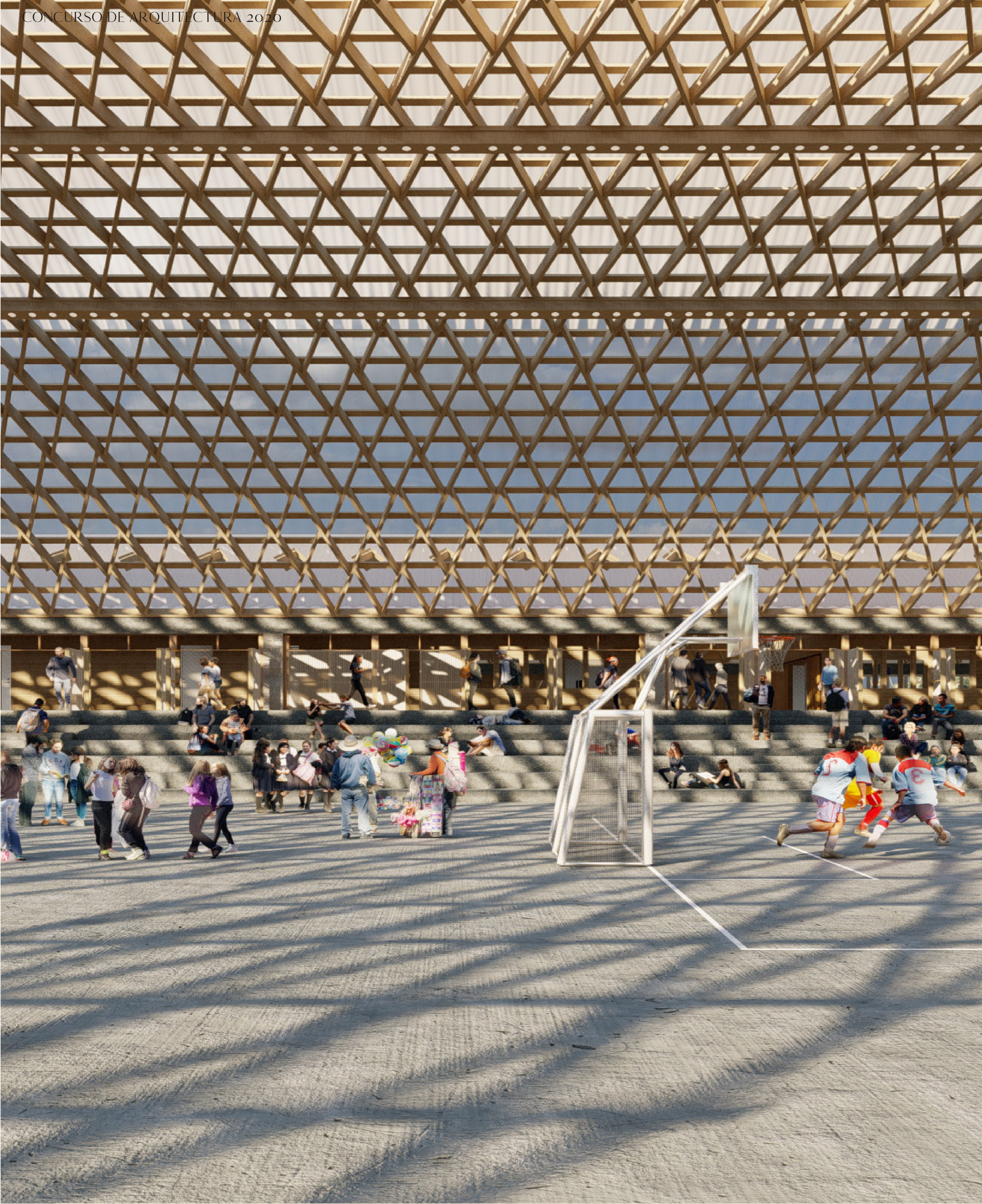
Interior, cubierta mercado municipal de Cauquenes. Interior, cubierta mercado municipal de Cauquenes. Cubierta con sistema Zollinger amelia en Alemania. Caballos transportando piezas prefabricadas de estructuras de lamella.
