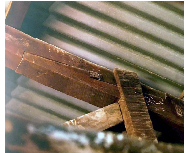
Imagen 1: Empalme rayo de júpiter en cercha (Gonzalez et al, 2019)
