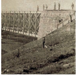
REFERENCIA PUENTE QUILLEM
