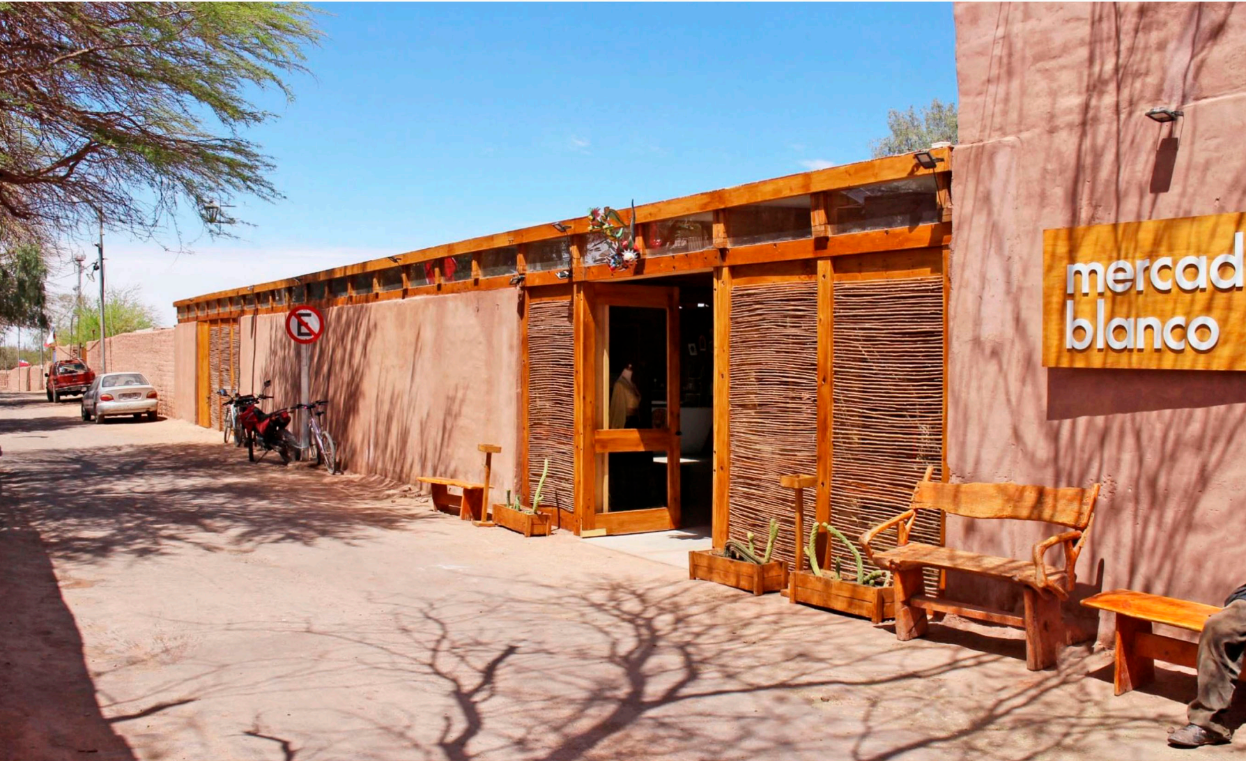
Envigado soportado por los centenarios muros de adobe. Emplazamiento en Zona Típica protegida.
