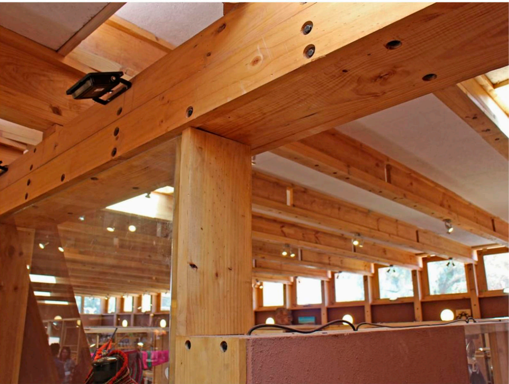
El sistema estructural de soleras, vigas y pilares parece volar sobre los pesados muros, y al mismo tiempo los confina y refuerza.
