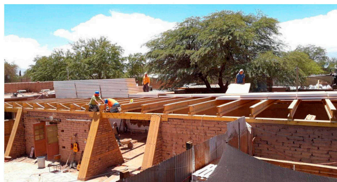
55 Vigas de pino cepillado doble T sobre soleras ancladas al adobe.
