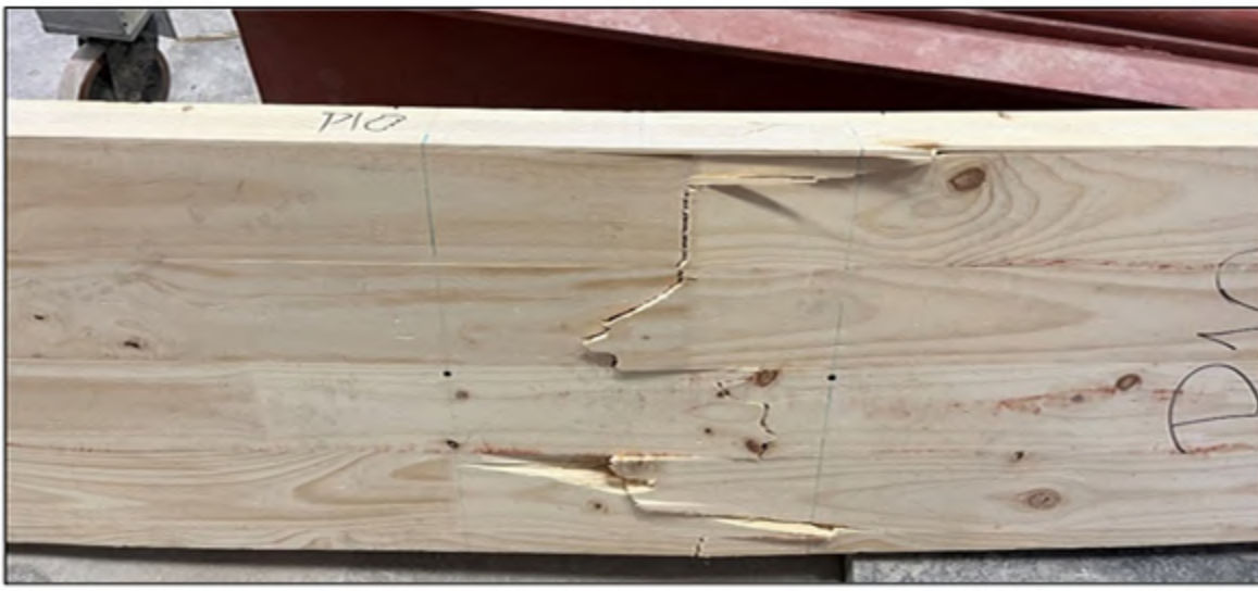
Figura 8 – Vista de la cara inferior de una falla a flexotensión en CLT de 3 capas.
